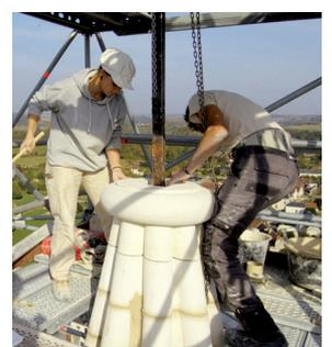
Les pierres sont ensuite posées, les joints et les lits sont fichés et coulés au mortier de chaux et sable. Sur les 4 400 pierres de la flèche, seules 105 d'origine sont reposées à leur emplacement exact. Dans les dernières assises sous le sommet de la flèche, la ferronnerie de la croix est réimplantée.
